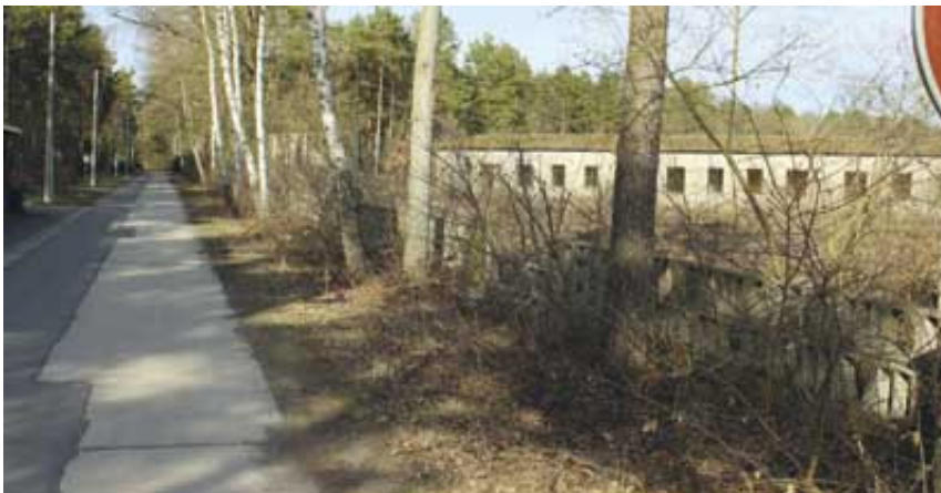
Ortsteil Hammermühle in Bad Düben:
